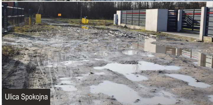
Prace budowlane w ul. Tymiankowej
