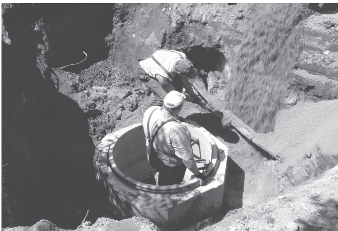
W trakcie prac w ul. Handlowej
