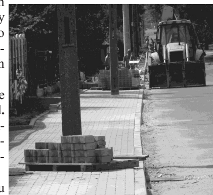
Chodnik w ul. Zachodniej, jeszcze w trakcie prac
