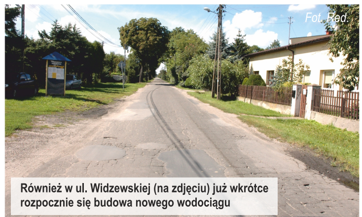
ul. Piaskowa (na zdjęciu) razem z ul. Bursztynową i ul. Spokojną - jeszcze w tym roku otrzyma nową sieć wodociągową i kanalizacji sanitarnej
