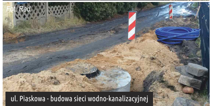
ul. Bereniki i nowa nakładka asfaltowa
