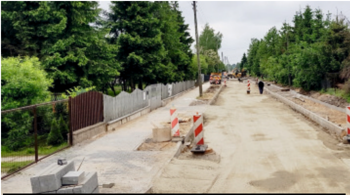
W ul. Wschodniej (odcinek od ronda do ul. Bednarskiej) jest już chodnik, budowlancy korytują drogę, układają krawężniki i budują ścieżkę rowerową
