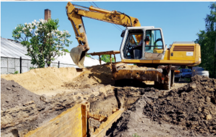
Budowa sieci wodno-kanalizacyjnej w ul. Głowackiego
