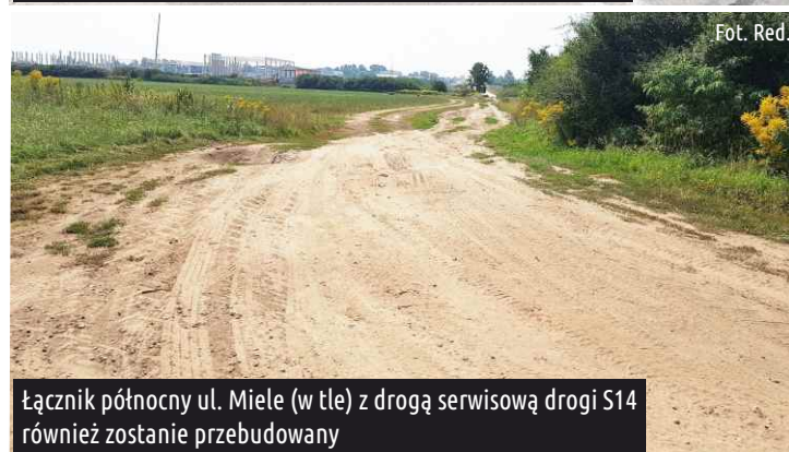
Skrzyżowanie ul. Rypułtowskiej z drogą serwisową drogi S14
