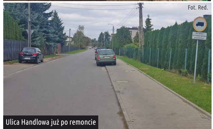
Przebudowa odcinka ul. Handlowej
