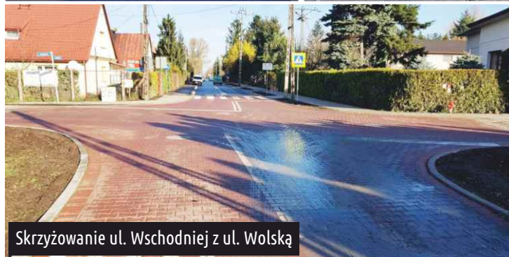
Ulica Wschodnia po i przed remontem
