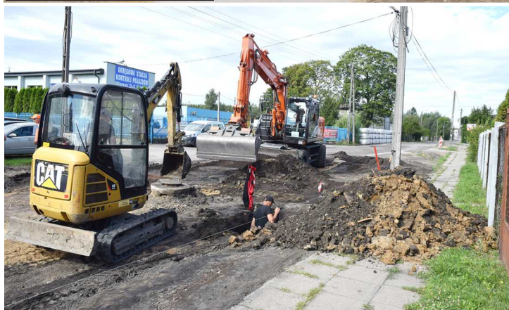
Remont ulicy Ksawerowskiej
