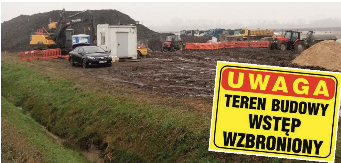
Zdjęcie przedstawia plac budowy nowej fabryki. Fotografia jest archiwalna.
