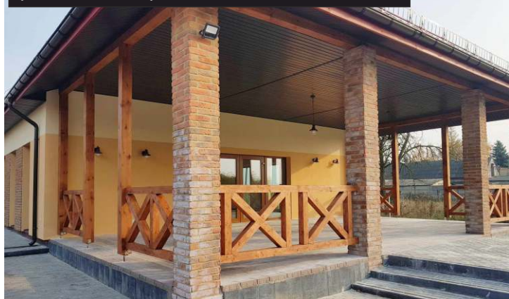
Tak jest - nowy budynek świetlicy wiejskiej (kwiecień 2019 r.)
