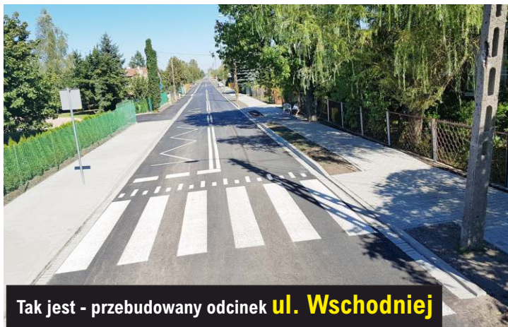
Remont pierwszego odcinka ul. Wschodniej
