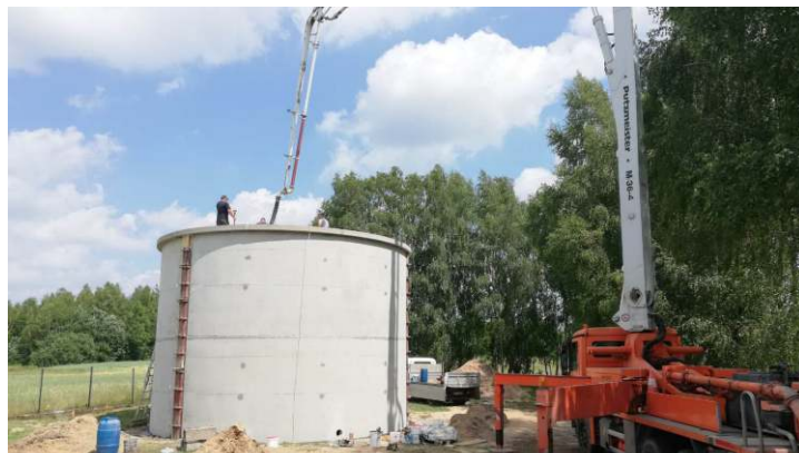
Montaż nowego zbiornika na terenie SUW (lipiec 2019 r.)
