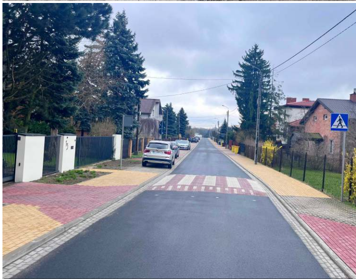
Tak jest - ul. Spółdzielcza po remoncie (wrzesień 2022 r.)
