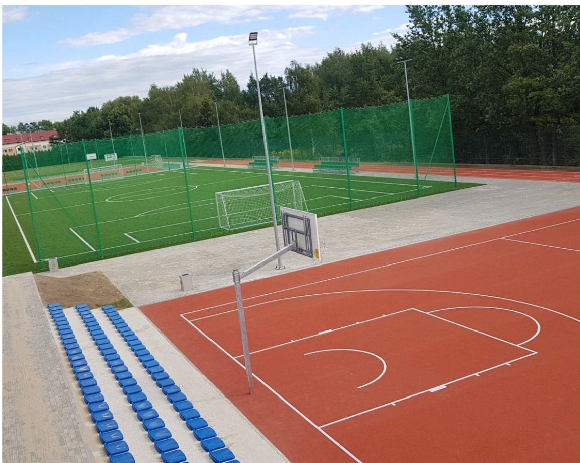
Fotografia przedstawia boiska po remoncie. Fotografie wykonała redakcja. Informację przygotowała redakcja.
