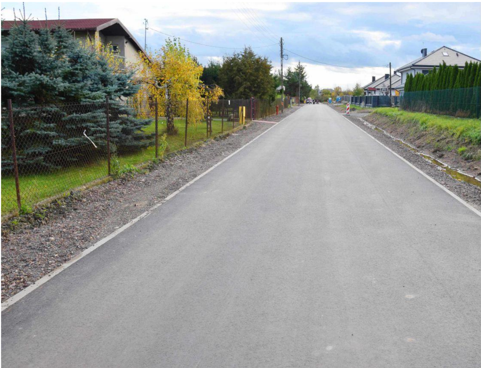
Fotografia przedstawia ulicę Prześwit po remoncie. Fotografie wykonała redakcja. Informację przygotowała redakcja.
