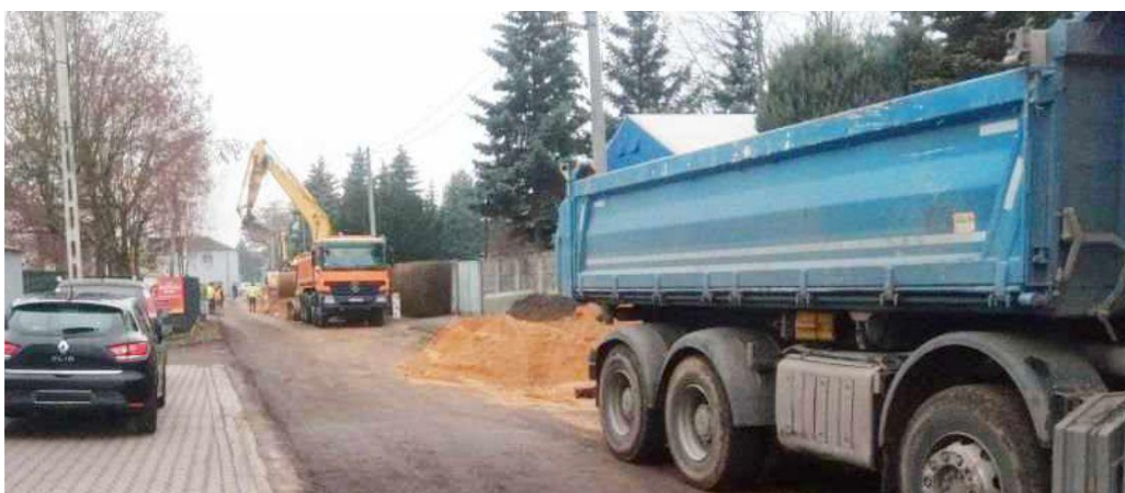
Fotografia przedstawia prace remontowe w ulicy Tymiankowej. Fotografie wykonała redakcja. Informację przygotowała redakcja.
