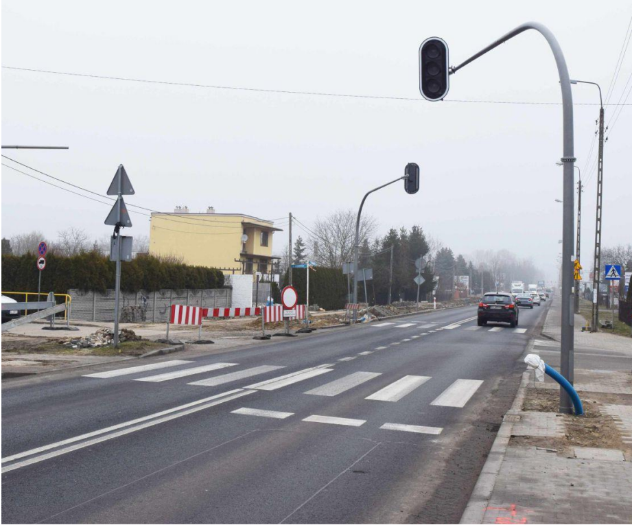
Fotografia przedstawia remont torowiska wzdłuż ulicy Łódzkiej. Fotografie wykonała redakcja.
