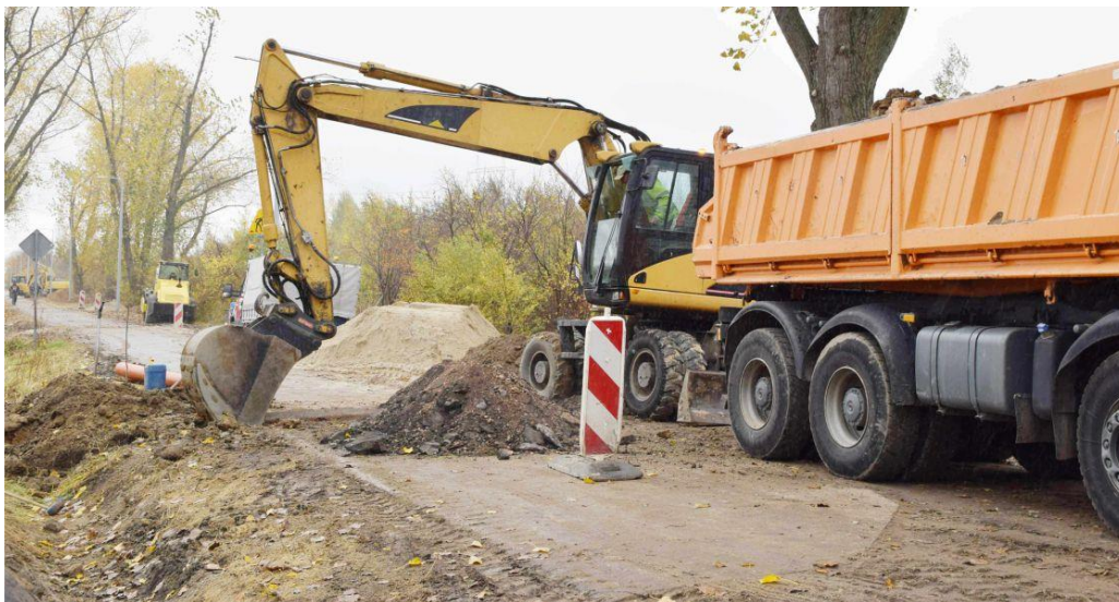
Fotografia przedstawia prace remontowe w ulicy Kosmowskiej. Fotografie wykonała redakcja.
