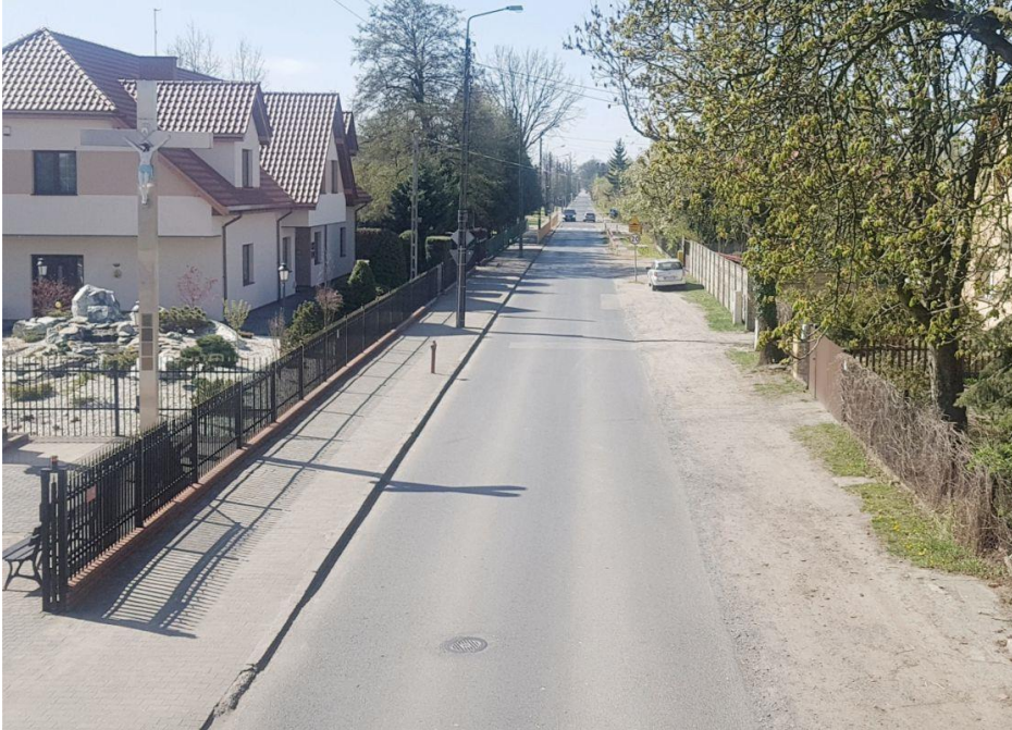
Fotografia przedstawia ulicę Zachodnią przed remontem. Fotografie wykonała redakcja.
