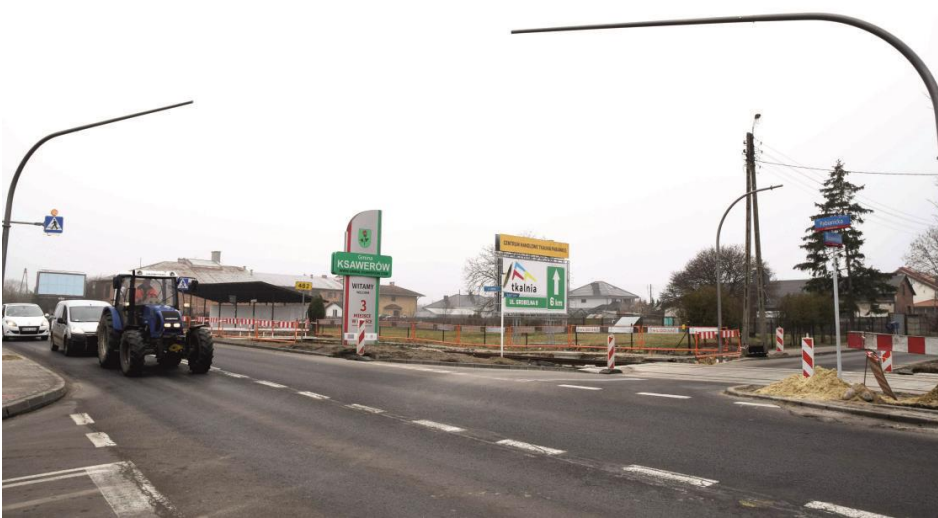
Fotografia przedstawia budowę sygnalizacji przy ulicy Łódzkiej. Fotografie wykonała redakcja.
