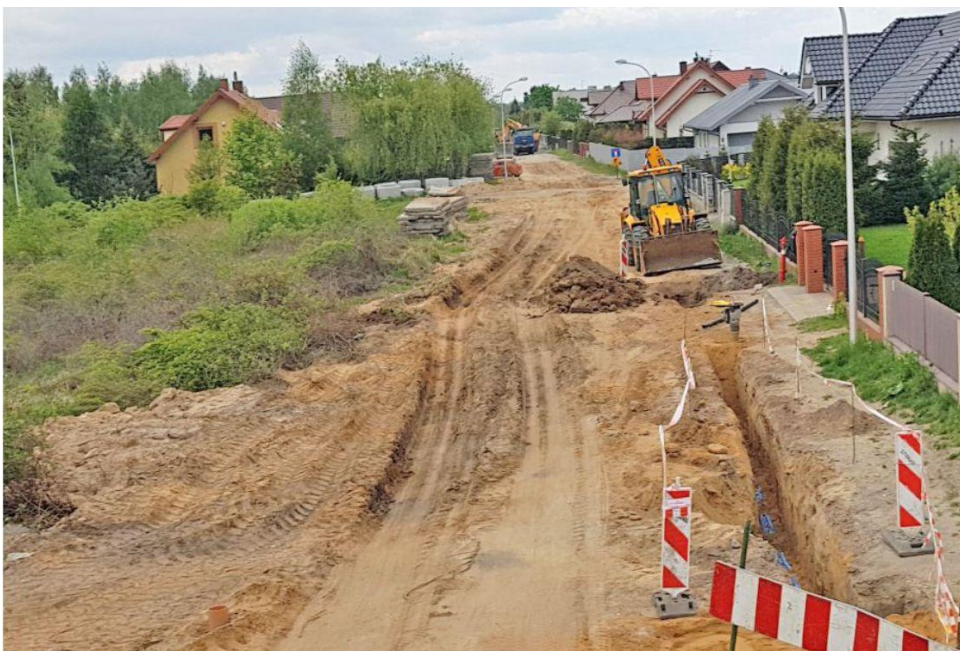
Fotografia przedstawia budowę sieci wodno-kanalizacyjnej w ulicy Bocznej. Fotografię wykonała redakcja.
