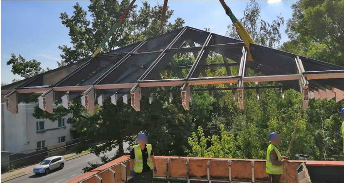
Fotografia przedstawia montaż nowego dachu. Fotografie wykonała redakcja.
