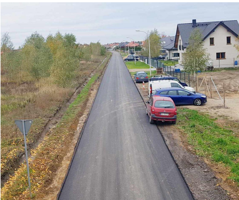
Fotografia przedstawia wyremontowaną ulicę Boczna. Fotografię wykonała redakcja. Informację przygotowała reakcja.
