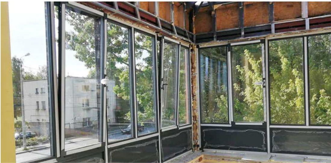
Fotografia przedstawia montaż nowego dachu. Fotografie wykonała redakcja. Informację przygotowała redakcja.
