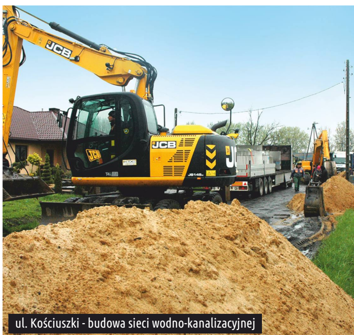
ul. Jęzmienna - przygotowanie pod nową nawierzchnię
